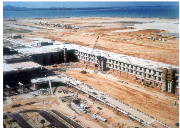
▲건설 중인 창이공항
